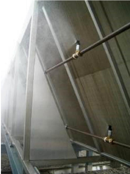
Abbildung 3: Bei der Verdunstungskühlung wird entgegen der Luftrichtung der angesaugten Luft Wasser fein vernebelt. (Alle Abb. Thermal)
